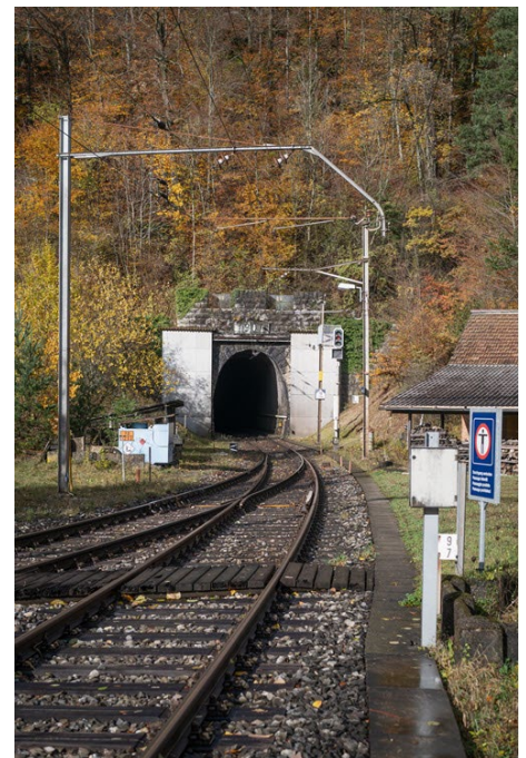
Tunnelportal in Oberdorf: Ab dem 4. März ist der Weissensteintunnel für den Bahnverkehr gesperrt.
