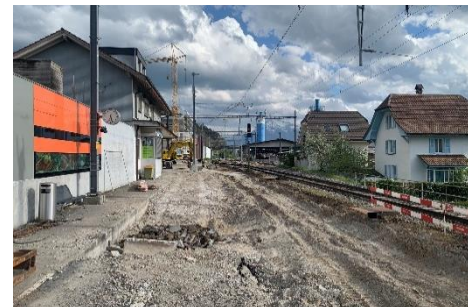
Rückgebautes Perron Gleis 1 / 2
