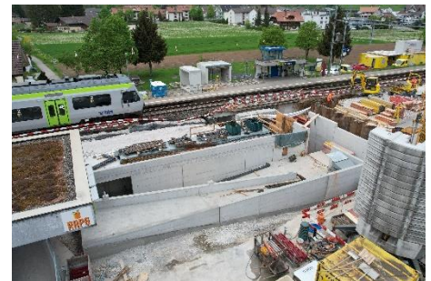
Neuer Zugang Ost zur Personenunterführung
