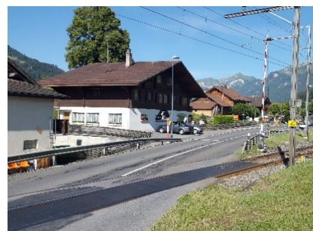
Der Bahnübergang Kantonsstrasse wird verlegt.
