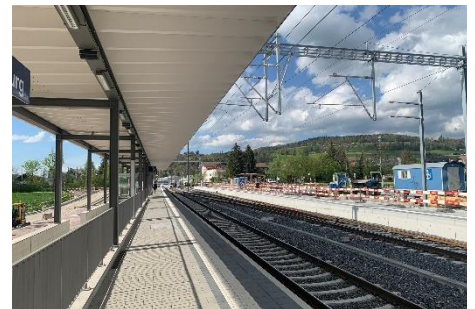
Blick von Perron 2 zu Perron 1
