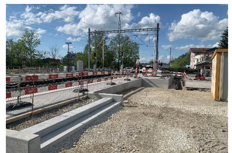
Perron 1 mit Tiefbauarbeiten Bahnhofplatz Ost
