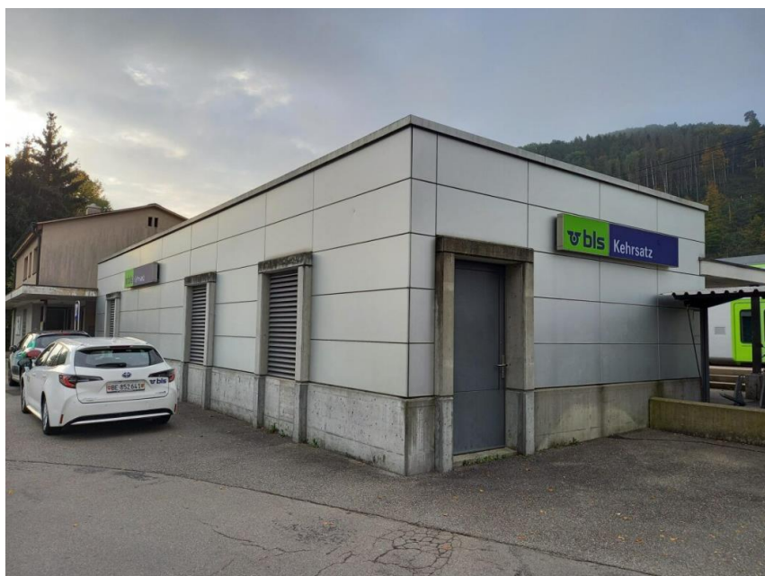
Abbildung 1 Technikgebäude beim Bhf Kehrsatz mit im Jahr 2023 saniertem Flachdach
