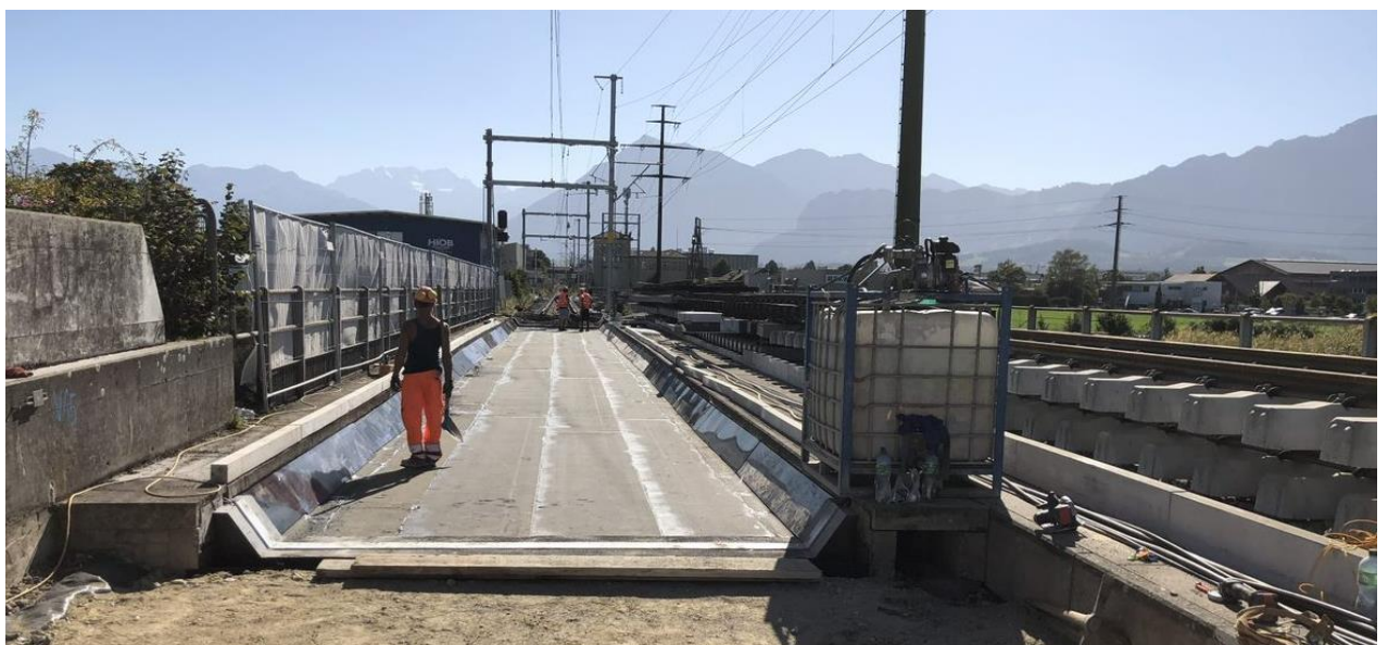
Abbildung 3 Erneuerung Brücke bei Steffisburg
