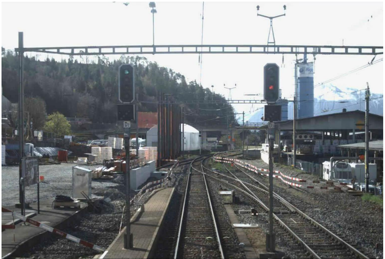
Abbildung 10 Umbau Bahnhof Heimberg
