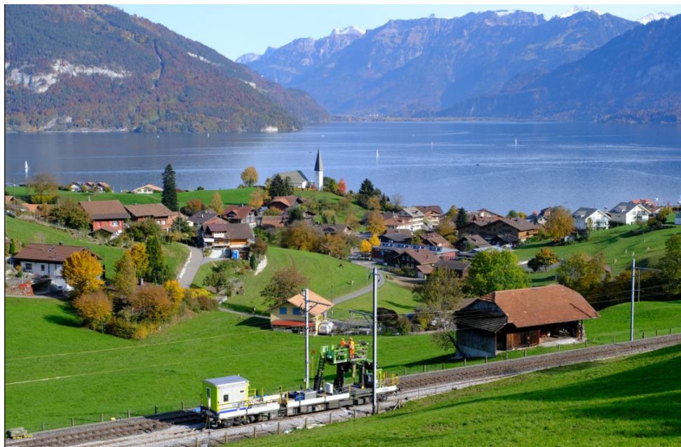
Abbildung 7 Instandhaltung Strecke Spiez-Interlaken West
