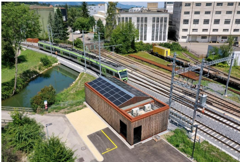
Abbildung 11 Technikgebäude Biberist Ost mit Photovoltaik-Anlage
